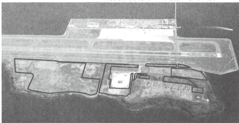
長崎空港の全景。黒線内の部分がメガソーラー用地 (写真は県提供、一部を加工している)
