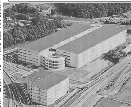
日本ベネックスが屋根を使ったメガソーラー事業を行う物流施設ロジポート流山の全景 ＝千葉県流山市(日本ベネックス提供)
